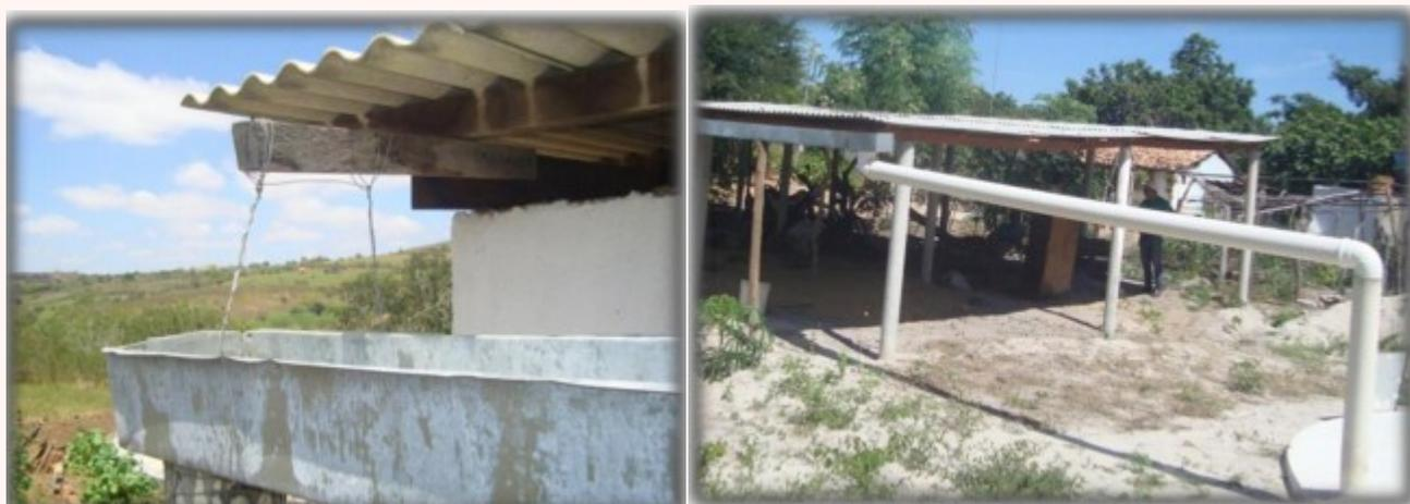
Na instalação da calha é importante observar um pequeno declive no sentido do tubo coletor para evitar que a água fique “empoçada” ao longo da canaleta, permitindo a reprodução de mosquitos.
