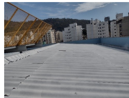
Reforma Telhado JFO
