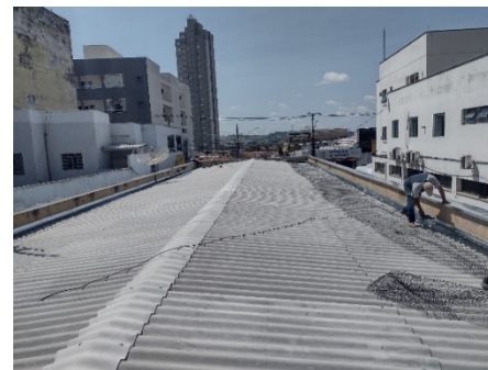
Reforma Telhado PAL
