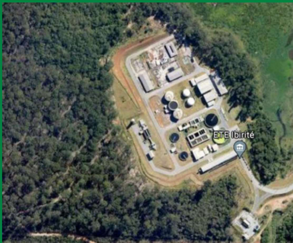
ETE Ibirité (Construída pela COPASA em terreno disponibilizado pela PETROBRAS).
