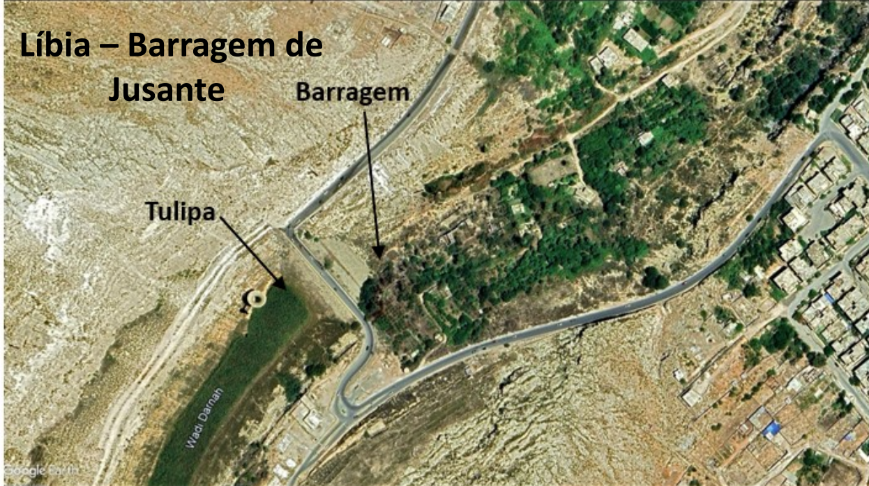
Barragem de jusante, situada no limite da área urbana de Derna , antes do rompimento.
