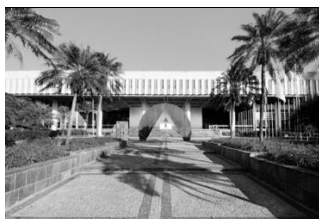
Fig.1 – Vista para a Fachada Frontal do Palácio da Inconfidência com detalhe para a escultura de Amílcar de Castro. Fonte: Dossiê de Tombamento Palácio da Inconfidência, CDPC/PBH, 2008.
