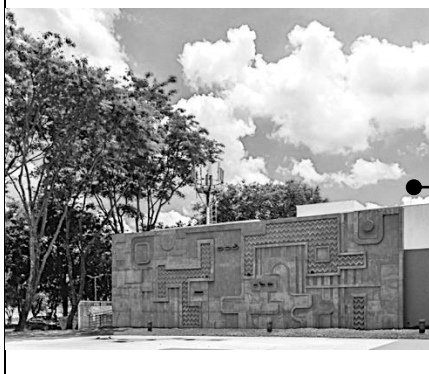
Fig.4 – Paineis de Burle Marx em concreto na Praça Carlos Chagas, 1974. Fonte: Dossiê de Tombamento Palácio da Inconfidência, CDPC/PBH, 2008.
