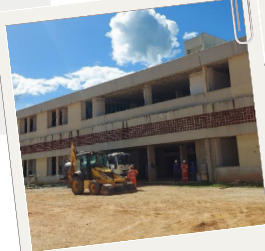
Teófilo Otoni em obras
