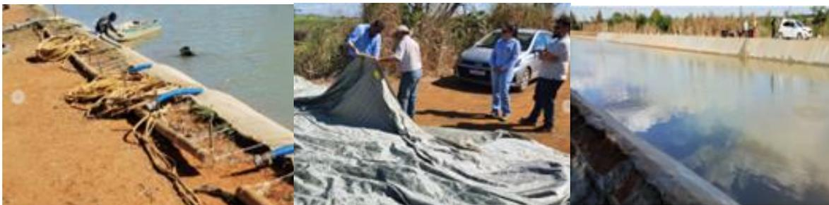
Fonte: Seapa - Mergulhadores vistoriando o Canal ; Preparação da Manta ; Visão do Canal CP3 com manta sendo aplicada
