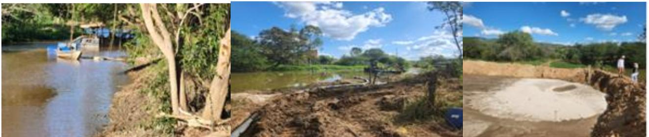
Fonte: Seapa - Desassoreamento visando captação de água para irrigação; desassoreamento visando captação de água para irrigação; área de descarte de material dragado
