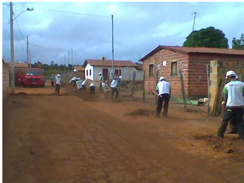
Construção de Rede coletora
