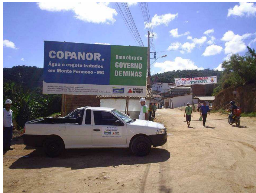
Construção de Rede coletora
