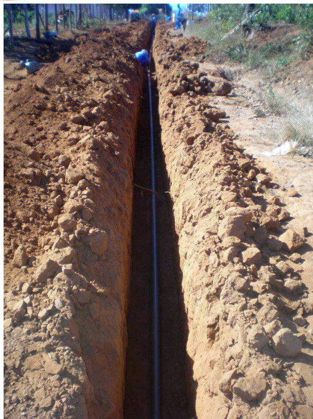
Construção de Rede de Distribuição
