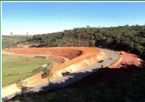
Foto – 13 – Execução do aterro estacas 598 a 624
