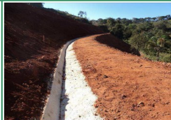
Foto – 14 – Sarjetas 1ª Banqueta – Aterro – Estacas: 600+10 a 616+15
