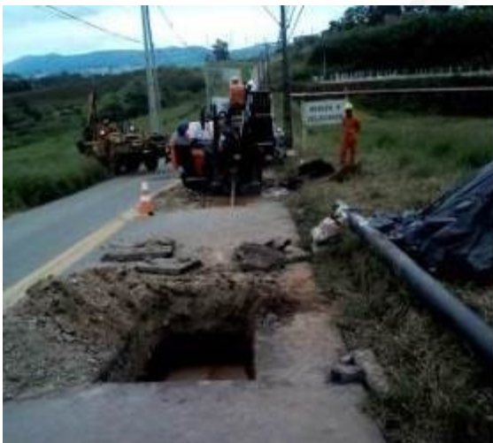
Execução de Furo Piloto
