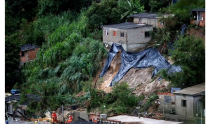
7/16 Equipes de resgate pesquisam o local de um deslizamento de terra, após fortes chuvas no bairro Vila Ideal em Belo Horizonte, em 24 de janeiro de 2020 (Cristiane Mattos/Réuters)
