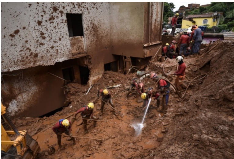
Na Vila Bernardete, em Belo Horizonte, um deslizamento de terra soterrou cinco casas
