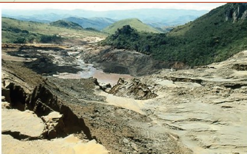
Figura 2.243 – Imagem de 30/05/1986 tirada a partir da barragem, olhando para jusante (Viotti, 2016b)
