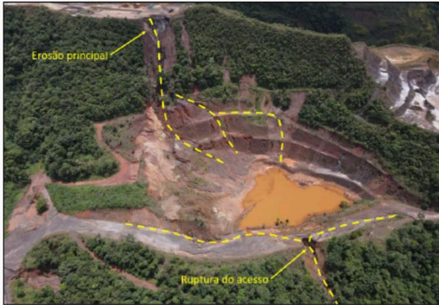
Foto 3 – Cava desativada a jusante do Sump1.
