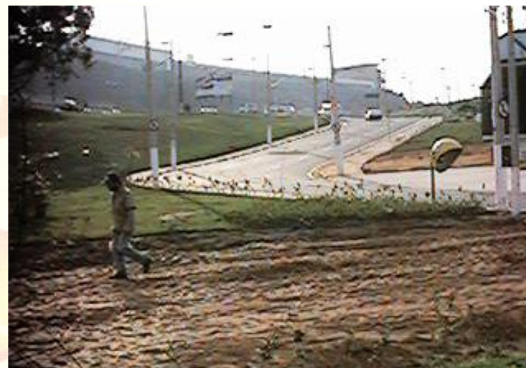
MELHORIAS TREVO KM 22 DA VIA ANCHIETA B. ASSUNÇÃO - S. BERNARDO
