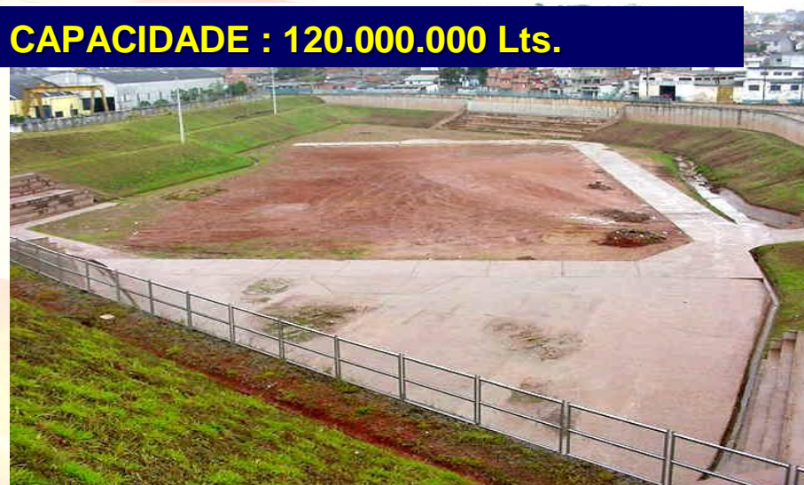
RESERVATÓRIO DE CONTENÇÃO VILA ROSA - SÃO BERNARDO
