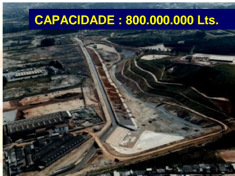
RESERVATÓRIO DE CONTENÇÃO PETROBRAS - MAUÁ
