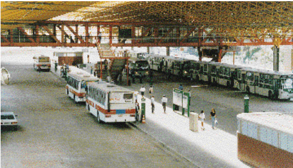
Nos terminais de transferência é possível realizar a integração entre diferentes sistemas de ônibus: linhas troncais e alimentadoras no terminal João Dias, São Paulo, atendendo linhas alimentadoras (à esquerda) e linhas troncais operadas por ônibus Padron (à direita).
