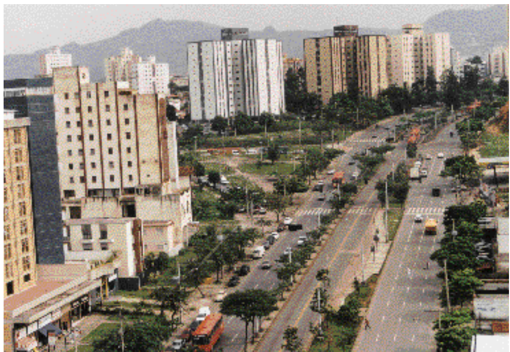
A canaleta é um excelente instrumento para definir espaço para o transporte público em vias largas (av. Cristiano Machado, Belo Horizonte).
