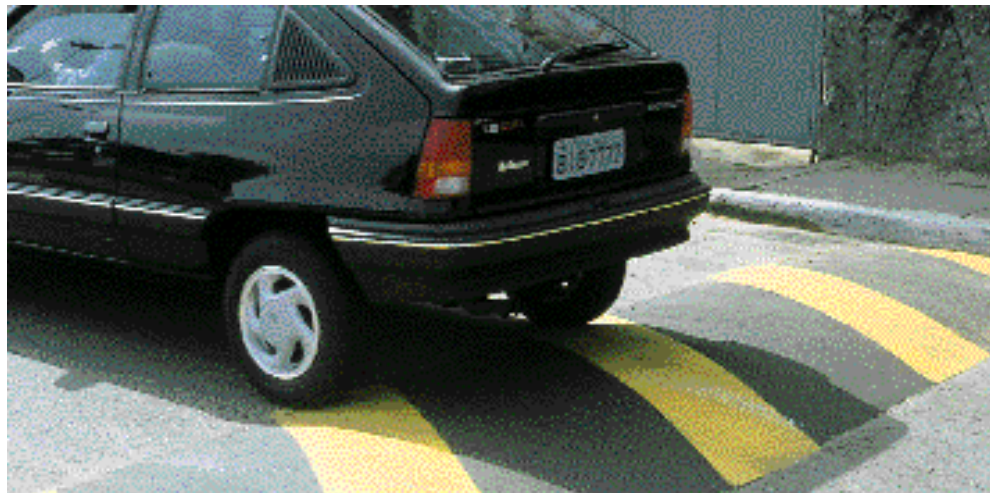
As lombadas, devidamente construídas, são dispositivos muito eficazes para redução de velocidade.
