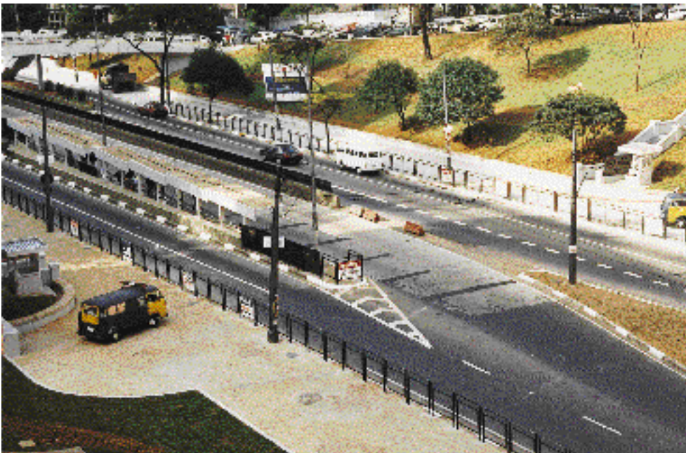
Em situações de risco de acidentes nas travessias, a implantação de gradis direciona o fluxo de pedestres, aumentando sua segurança (av. 9 de Julho, São Paulo).
