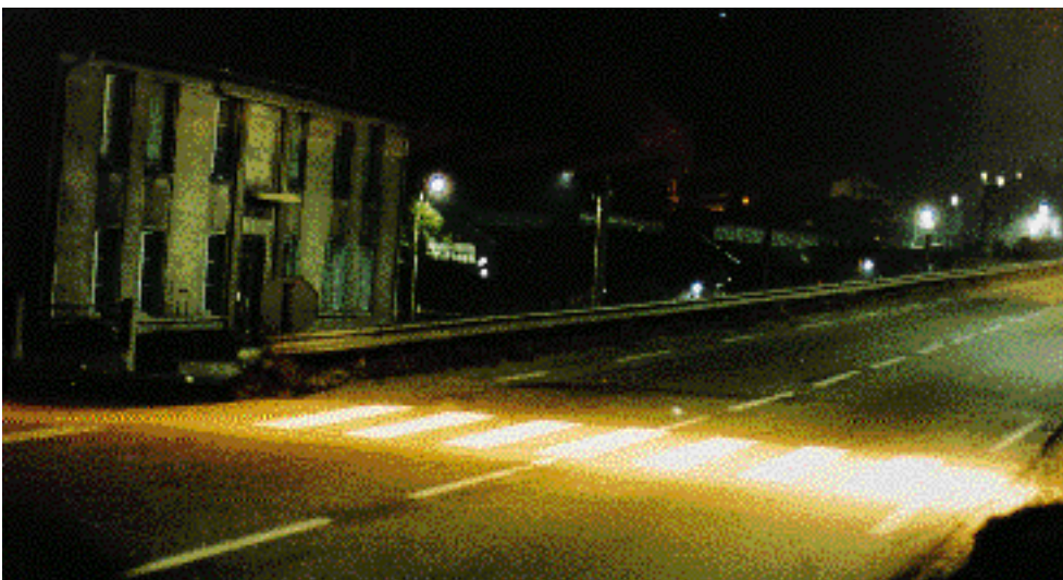
A faixa iluminada de pedestres melhora a visibilidade da travessia no período noturno, aumentando a segurança.
