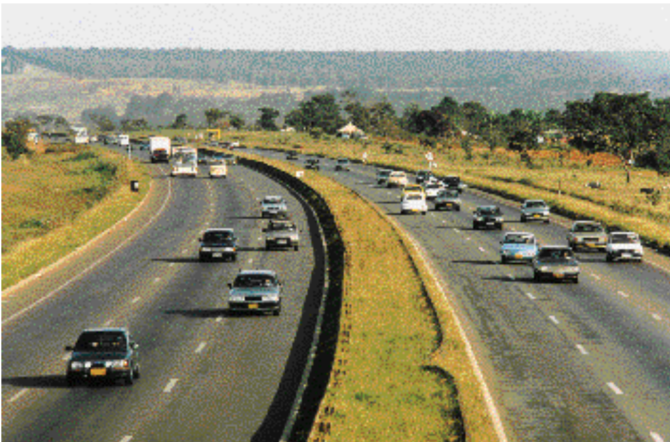
A reversão do sentido de circulação de uma pista, em horários de pico, acrescenta capacidade viária extra com baixo custo, reduzindo o congestionamento (via Estrutural, Brasília).
