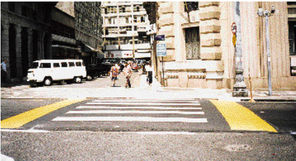
A faixa de pedestres na altura da lombada garante proteção adicional à travessia.
