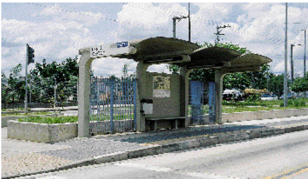
Em sistemas estruturais de transporte é fundamental o tratamento das paradas, com a adoção de abrigo, banco, lixeira e informações básicas sobre o sistema (corredor São Mateus-Jabaquara, RMSP).
