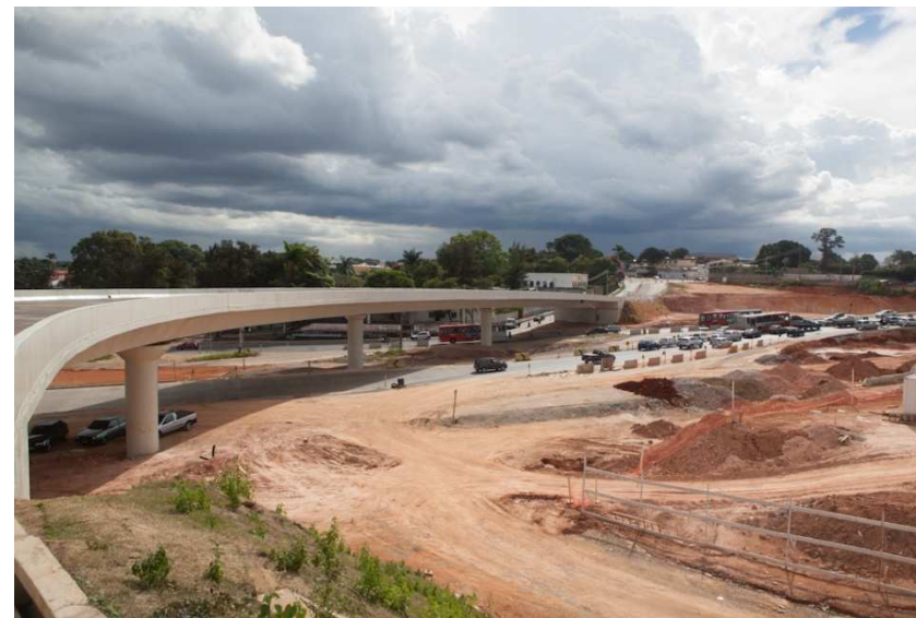
Viaduto “Niemayer”, recém concluído
