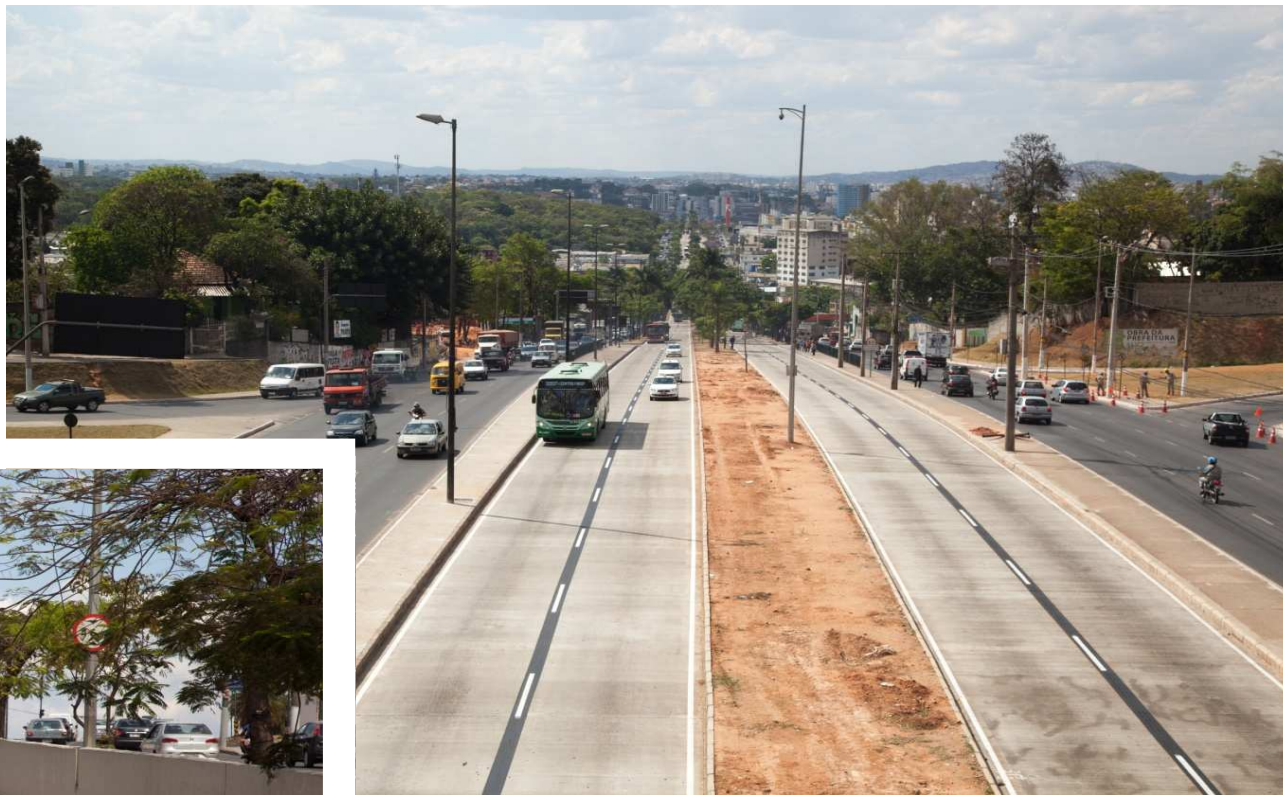
Busway no sentido Centro/Bairro: obra concluída
