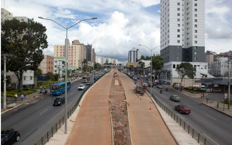
Trechos concluídos da busway , em pavimento de concreto
