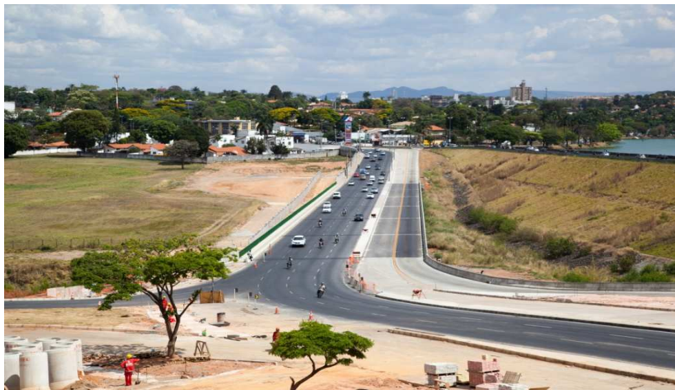
Busway de acesso ao Terminal (a dir.): concluída
