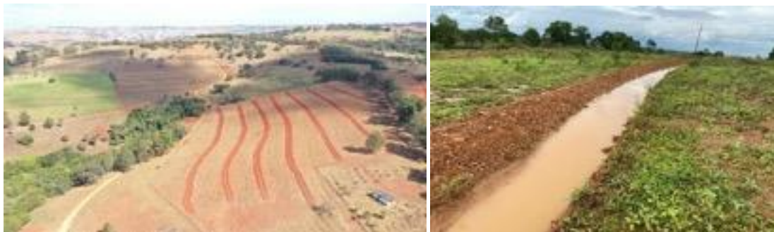
Construção de terraços e barraginhas no município de São Gotardo – MG / Construção de terraços no município de Lagoa Grande – MG. Fonte: SEAPA.
