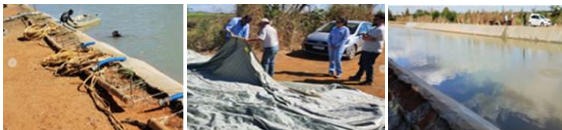
Fonte: Seapa - Mergulhadores vistoriando o canal; preparação da manta; visão do Canal CP3 com manta sendo aplicada
