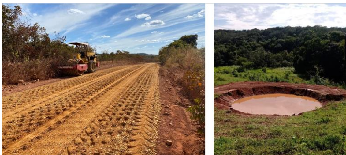
Adequação ambiental de estradas no município de Francisco Dumont- MG / Construção de barraginhas no município de Várzea da Palma - MG. Fonte: SEAPA.
