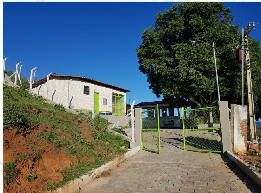
ETA, com implantação de sistema de redução de Fe/Mn, pavimentação do acesso, reforma do almoxarifado e da casa de química e construção de bacia de contenção em Bandeira.
