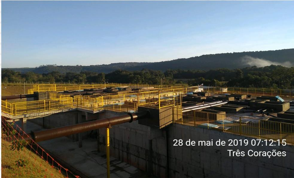
Ampliação do Sistema de Esgotamento Sanitário do município de Três Corações: Reatores UASB
