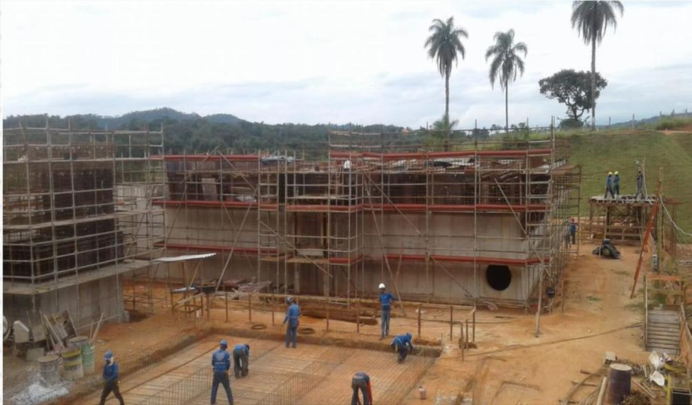
Ampliação do Sistema de Esgotamento Sanitário do município de Ribeirão das Neves ETE Santinho: Reator UASB
