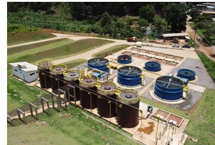
Sistema de Esgotamento Sanitário (SES) no município de Divino
