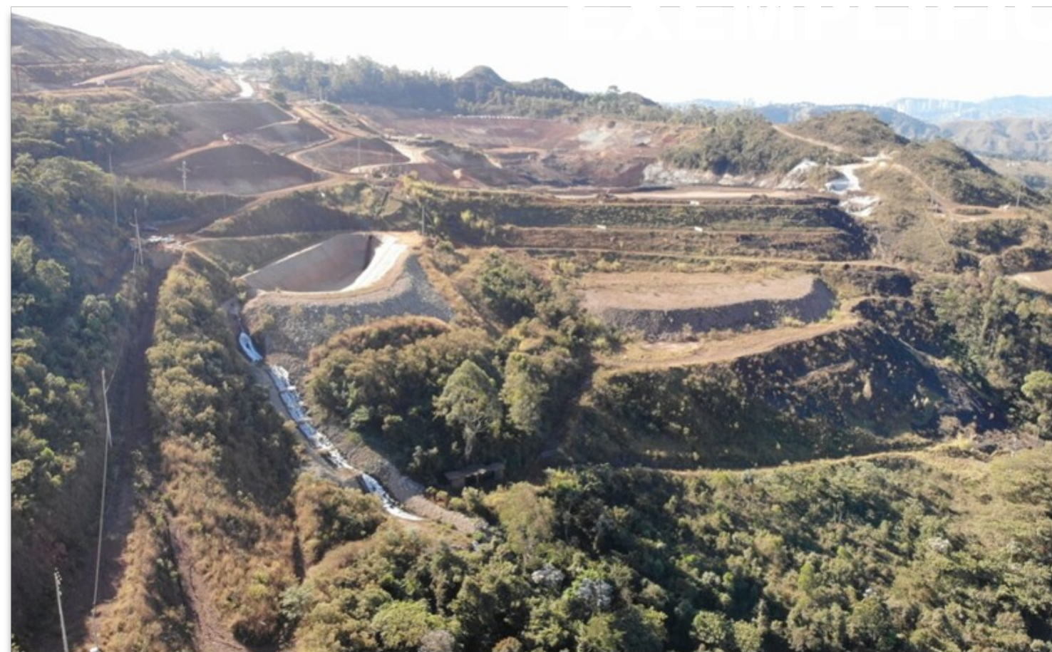
Visão geral agosto 2022 (Etapa 5) Fonte: voo de drone em vistoria da ANM
