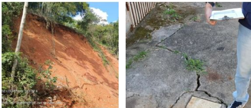
Figura 3 - Feições de instabilidade do terreno
