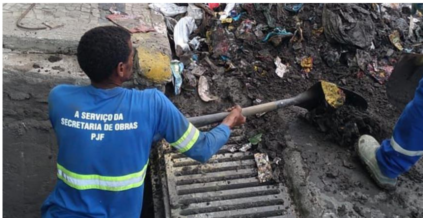
Figura 19 - Limpezas de bocas de Lobo - Cerca de 617 Toneladas de Lixo Retiradas em 2023.
