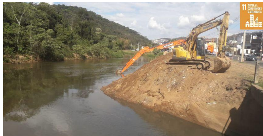
Figura 20 - Desassoreamento de cursos d'água
