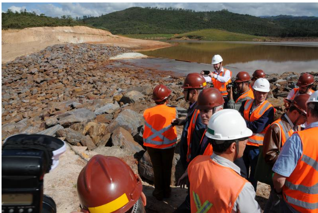
Figura: Dique S3 será alteado em dois metros.
