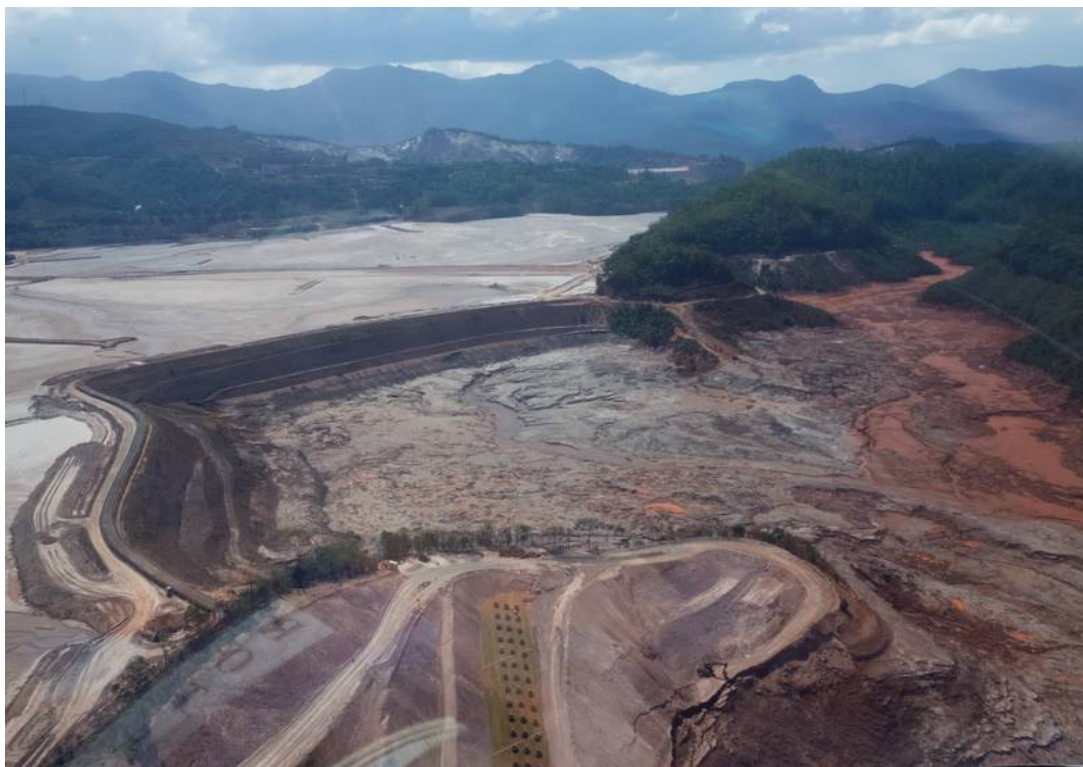
Figura 4 – Barragem de Fundão após o rompimento
