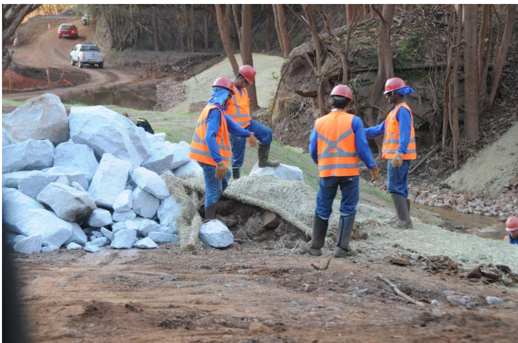
Figura: Manta sendo colocada às margens do rio sobre lama acumulada.
