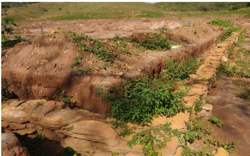
Figura: Muro de pedra em Bento Rodrigues protegido pelo IPHAN
